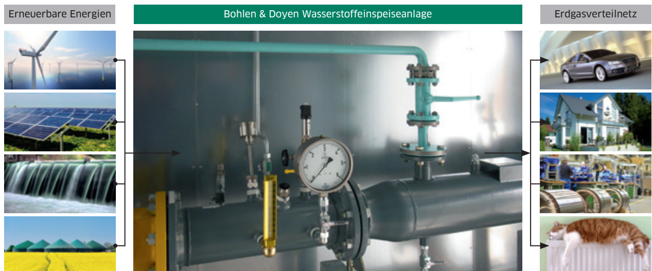
Wasserstoffeinspeiseanlage für die Einspeisung von Wasserstoff in das kommunale Gasverteilernetz in Frankfurt am Main
